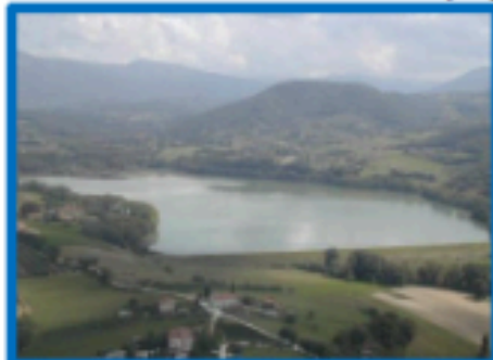
Diga de l'Aia (Lago di Recentino)
